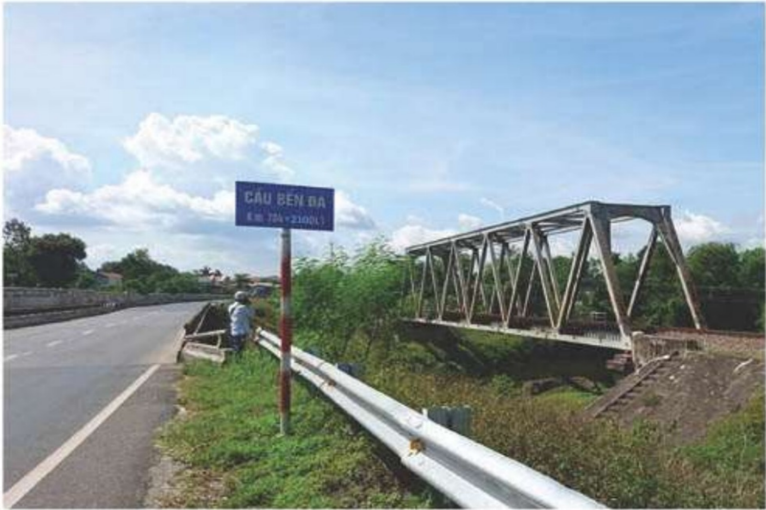
Cầu Bến Đá ở km 784.210, chụp từ bờ bắc hướng về Huế
