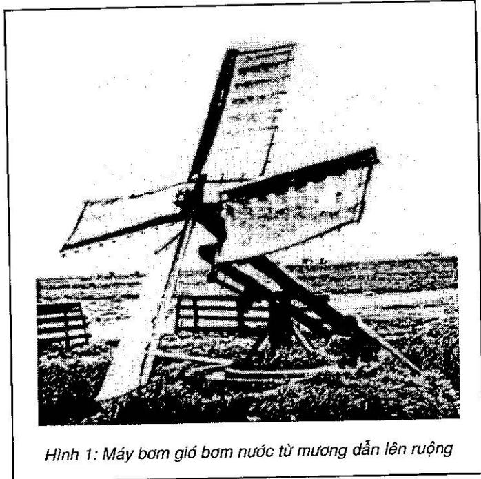
Hình 1: Máy bơm gió bơm nước từ mương dẫn lên ruộng
