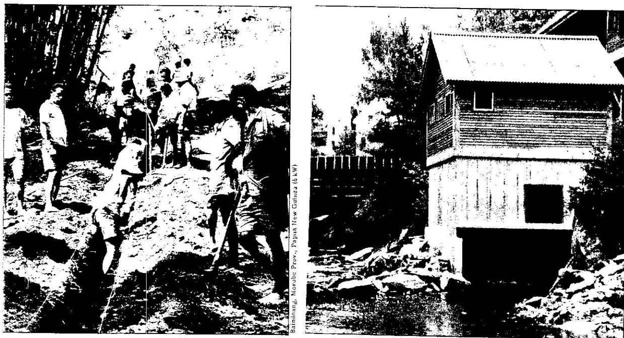
Hình 6 : dân làng chung sức đào mương chôn ống dẫn nước. Bên phải là nhà máy thủy năng.
