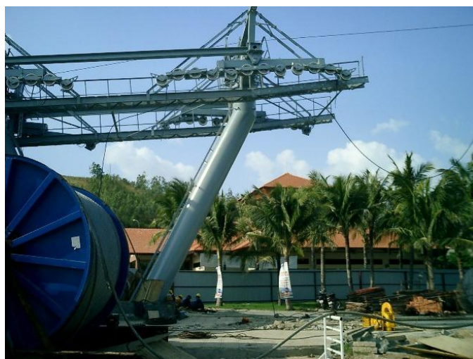
(Đang kéo sợi cáp D52mm)
