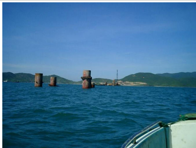
(Cọc ống hạ đúng vị trí thiết kế)
