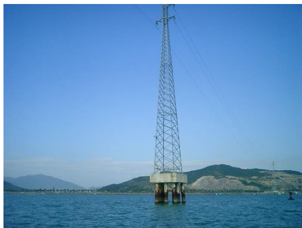
(Móng trụ điện vượt biển ra đảo)
