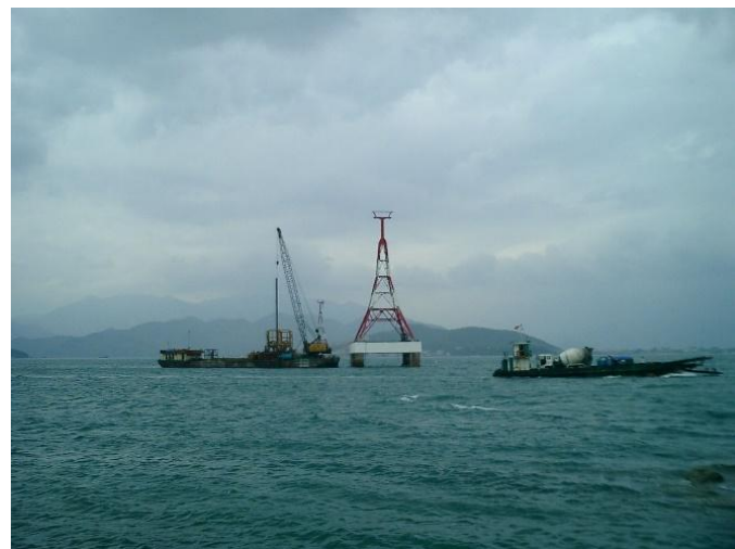
(Vận chuyển bê tông bằng sà lan)
