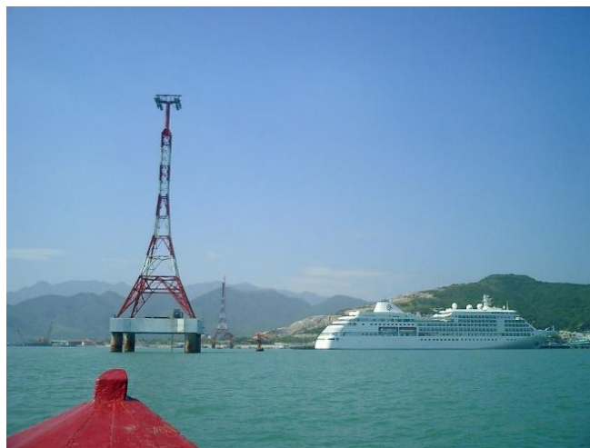
(Trụ cáp treo đang được hoàn thiện)
