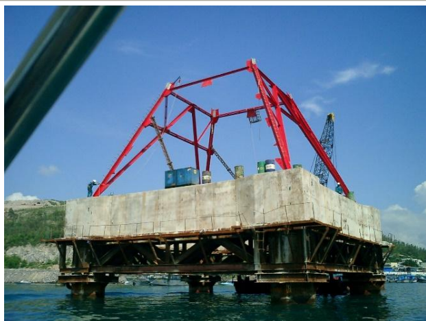
(Đài cọc bê tông cốt thép đổ tại chỗ)
