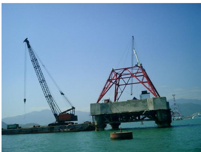
(Lắp đặt trụ tháp dạng Eiffel)
